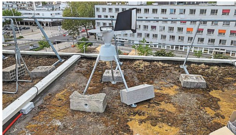
Ce capteur de pollens, installé sur le toit de la mairie, permet d'estimer l'intensité du risque d'allergie au fil des semaines.
